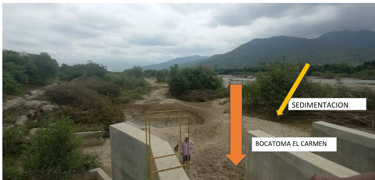
Figura N° 02: Se observa la margen izquierda del río Piura totalmete colmatada en el Sector El Carmen.
