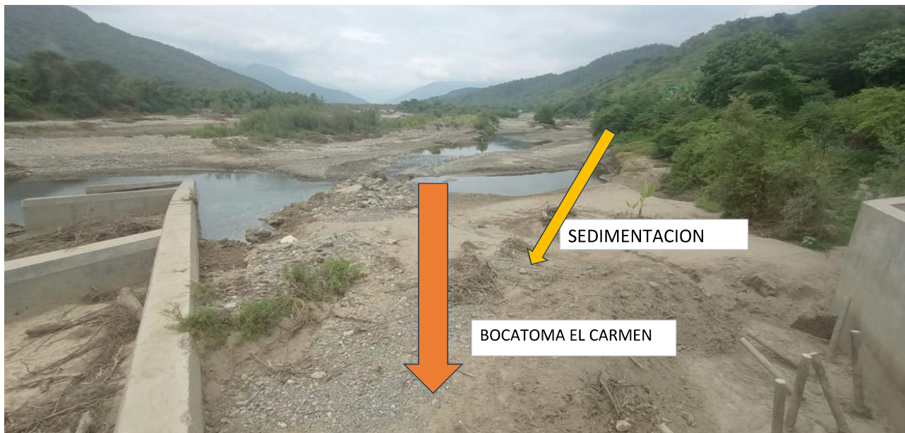
Figura N° 01: Se observa la margen izquierda del río Piura totalmete colmatada en el Sector El Carmen.
